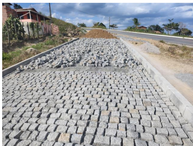
FOTO 2: Pavimentação em paral. Graníticos - Rua 01
