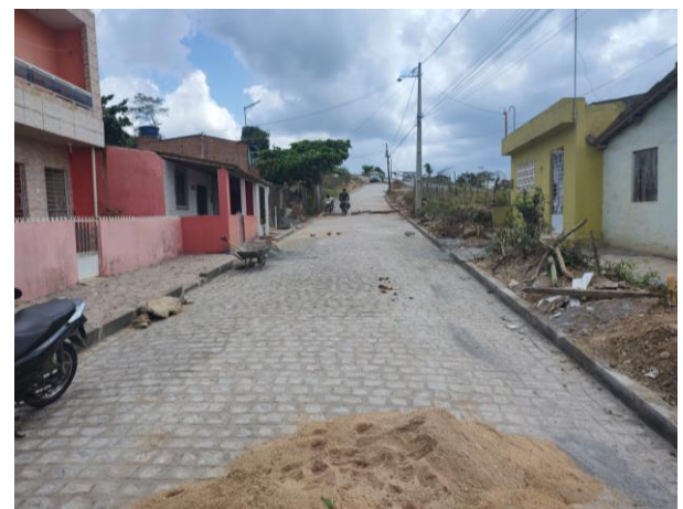
FOTO 5: Pavimentação em paral. Graníticos - Rua 01
