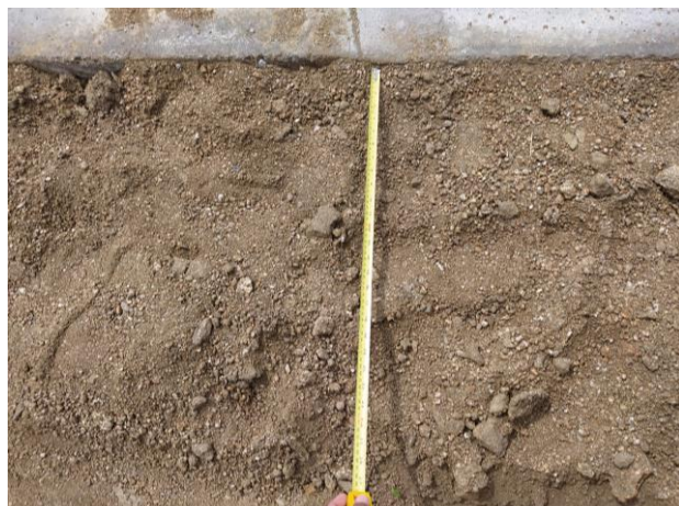
FOTO 6: Pavimentação em paral. Graníticos – Escoramento do MF - Rua 01
