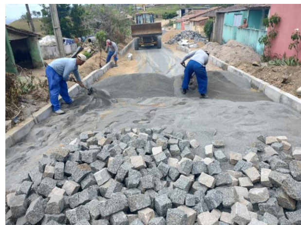
FOTO 4: Pavimentação em paral. Graníticos - Rua 01
