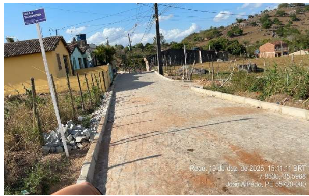
FOTO 2: Rua 2 – Pavimentação em paralelepípedos.
