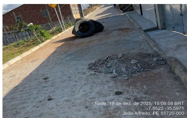
FOTO 4: Rua 2 – Pavimentação em paralelepípedos.
