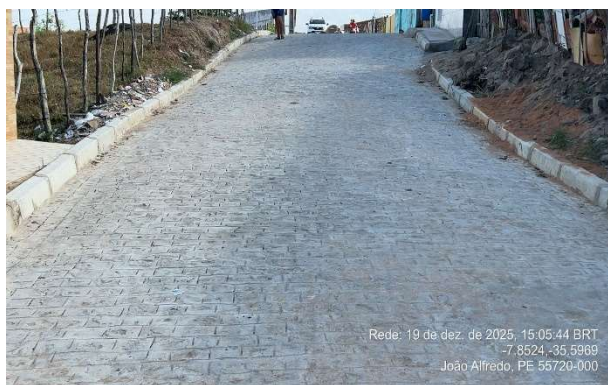
FOTO 1: Rua 2 – Pavimentação em paralelepípedos.
