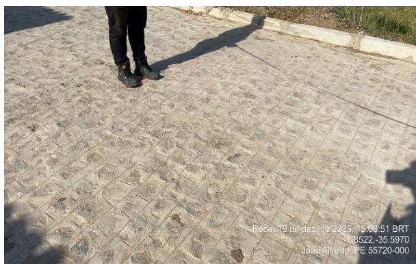
FOTO 5: Rua 2 – Pavimentação em paralelepípedos.
