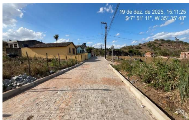
FOTO 6: Rua 2 – Pavimentação em paralelepípedos.
