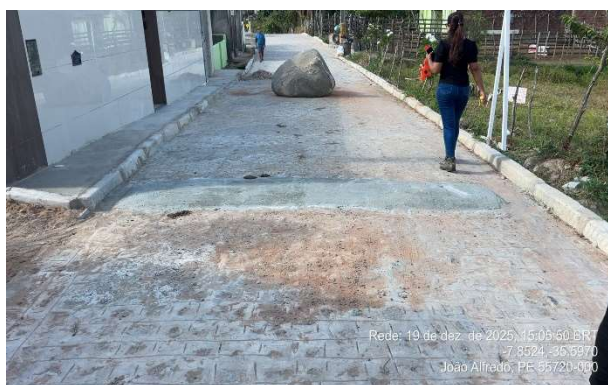
FOTO 3: Rua 2 – Pavimentação em paralelepípedos.
